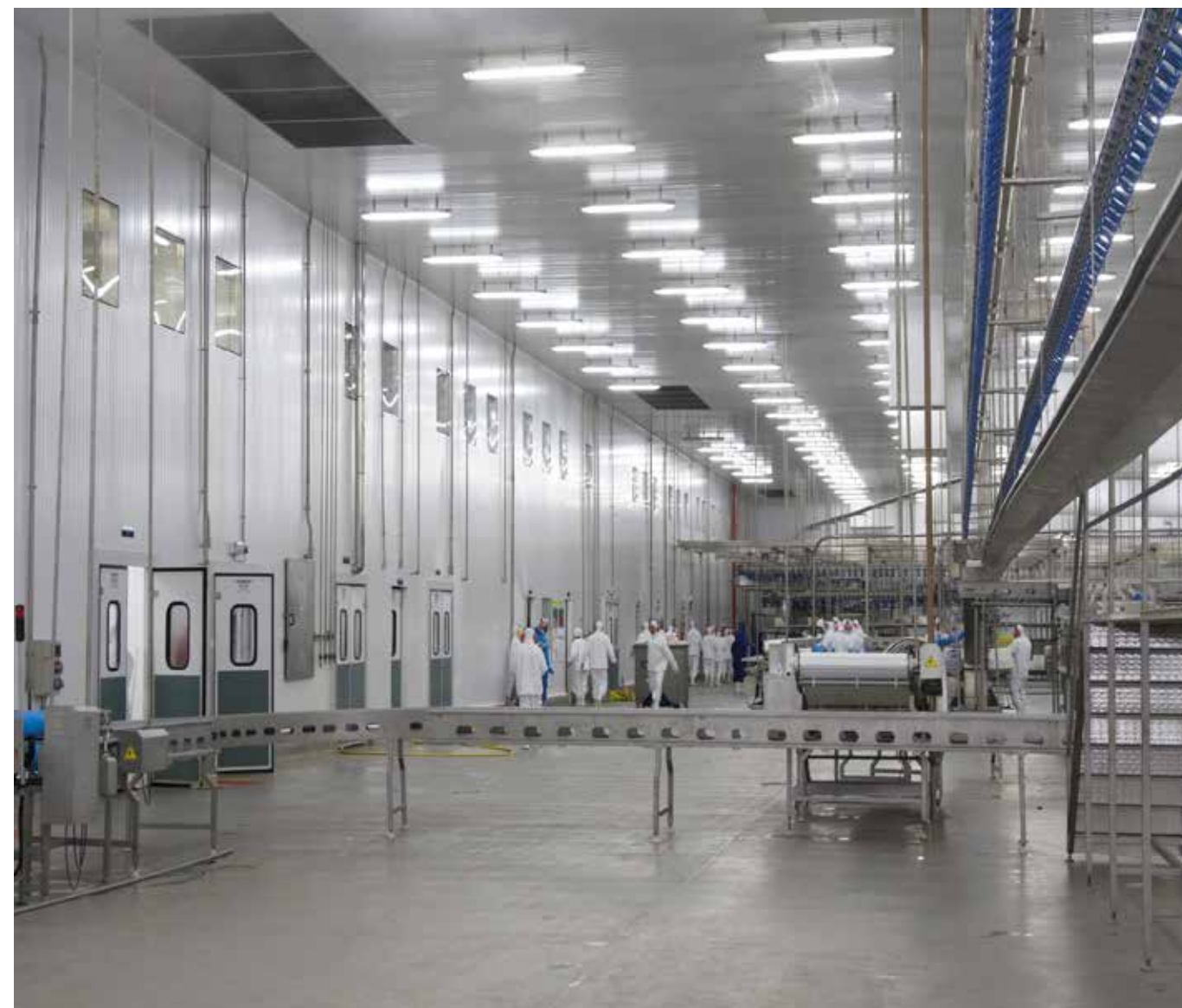
Frigorífico Sadia - Lucas do Rio Verde - MT
